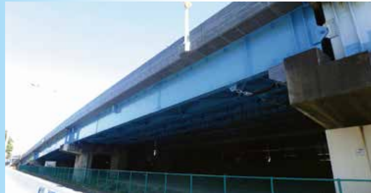
■舞浜大橋右岸ラフ*橋(山側)【関東地方整備局】
