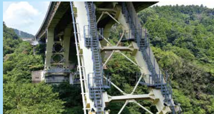
■田浦第二高架橋耐震補強工事【東日本高速道路株】
