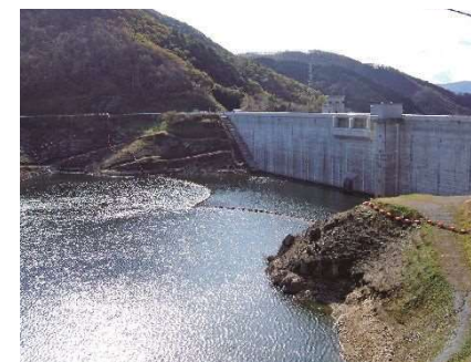
鷹生ダム流木止設備 (岩手県) 延長402m (網場部:396m、通航ゲート部:6m) 2004
