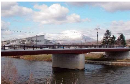
栴沢橋 (盛岡市) 橋長57.3m×幅員10.5m 2径間連続合成床版橋 (中空タイプ) 2015
