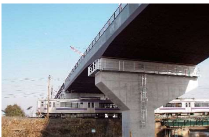
久田前田中線橋梁 (奥州市) 橋長58.2m×幅員14.8m 2径間連続合成床版橋 (中空タイプ) 2014
