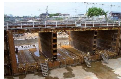
内部掘削函体完成 (株)ジェイテック提供
