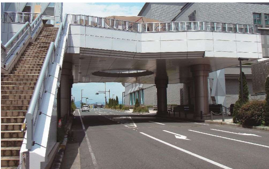
盛岡駅西口2号線人工地盤 (盛岡市) 橋長38.8m×幅22.8m、106t 立体ラーメン箱桁橋 2002
