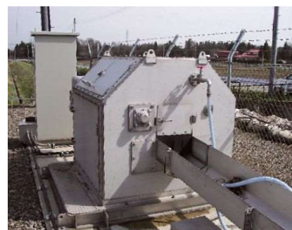
江釣子地区除塵機 (岩手県) 水路断面幅2.0m×高3.5m 縦型ネット式除塵機 2003
