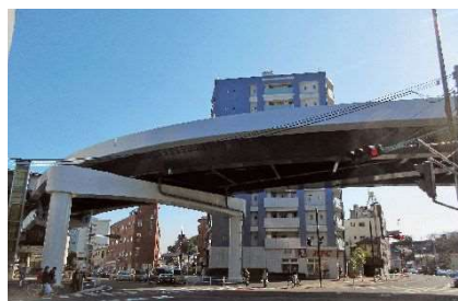
金沢シーサイドライン高架橋 (横浜市)
