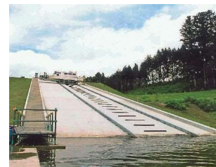
北上川係船設備 (国土交通省) 走行距離97.04m×走行路幅5.2m インクライン方式 (鋼製台車・電動ワイヤロープウィンチ式) 2000
