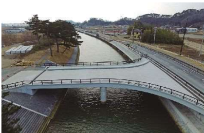
亀岡新橋 (東松島市) 橋長31.8m×幅員13.25m 2径間連続合成床版橋 (充実タイプ) 2019
