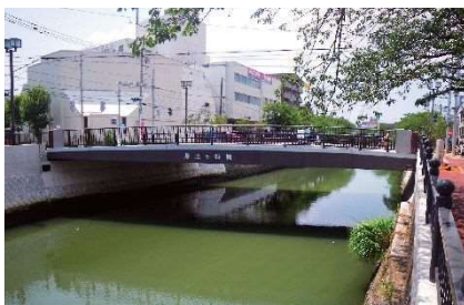
井土ヶ谷橋 (横浜市) 橋長59m×幅員17.2m 単純合成床版橋 (中空タイプ) 2013
