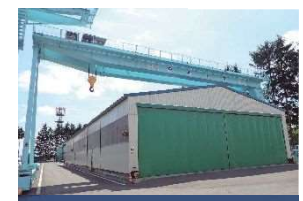
移動式塗装小屋 (2棟) 及び橋形クレーン 30t/5t
