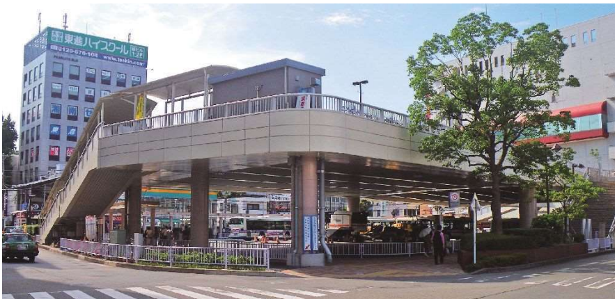
鶴見駅西口第二自転車駐車場 (横浜市) 橋長55.8m×幅24.6m、384t 立体ラーメン鋼床版桁 2012
